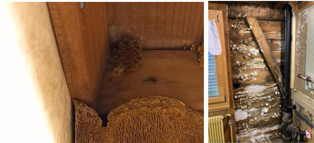
Die anschliessende Kontrolle durch den Spengler hatte ergeben, dass wegen einer defekten Dacheinfassung durch das Dach Wasser eingedrungen war und im Zwischenraum der Aussenwand zu Feuchteschäden und Pilzwachstum geführt hat, zum Glück kein gefährlicher Schimmelpilz.
