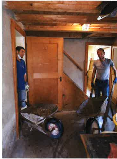
Füllen der Erdwasserspeicher mit Geröll
