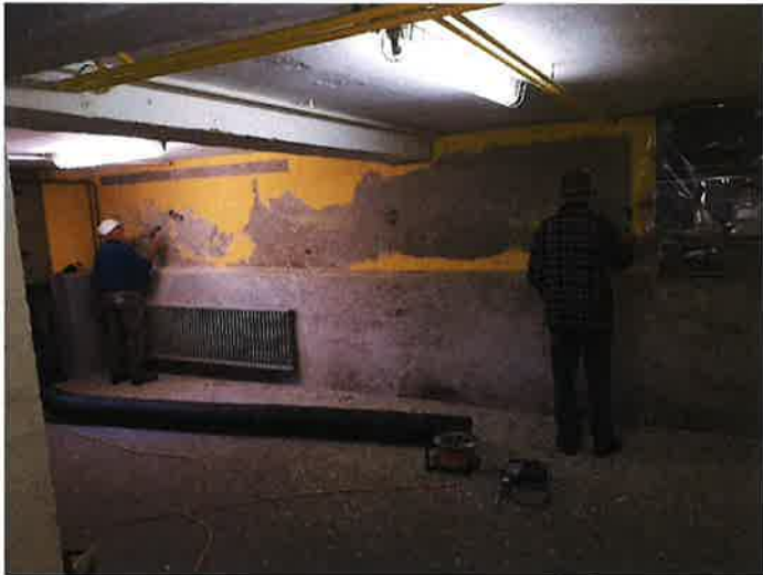
Alter Verputz abspitzen
