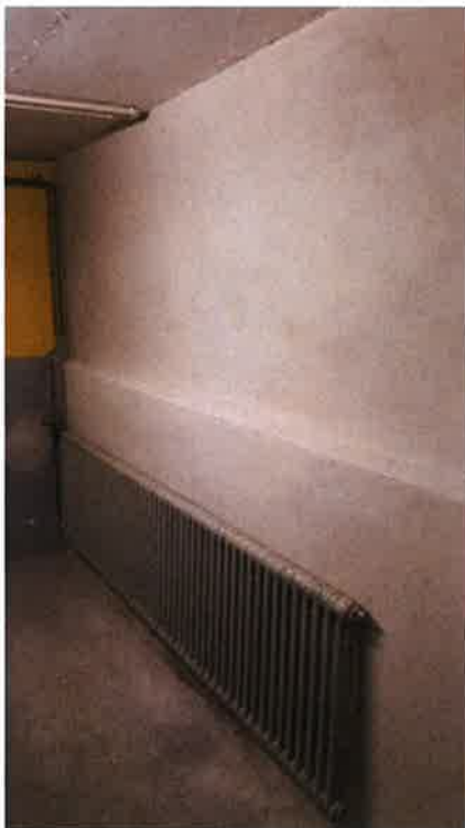
Neu verputzte Wand im Keller
