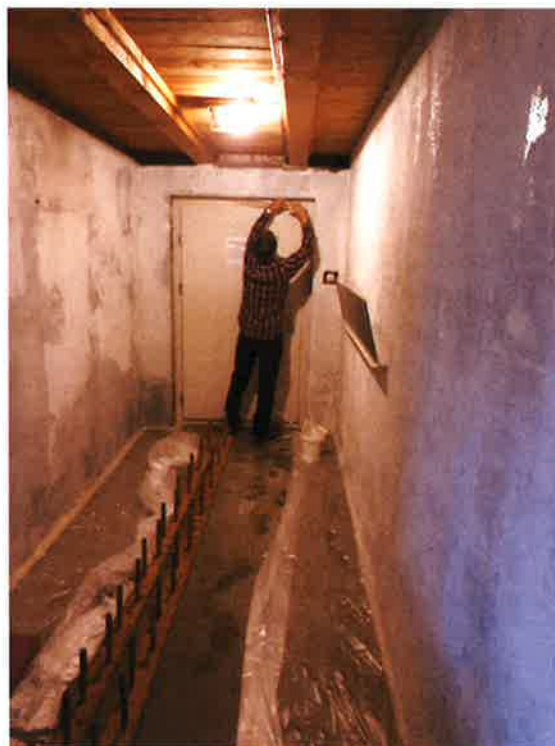
Eingang Keller wird auch gestrichen
